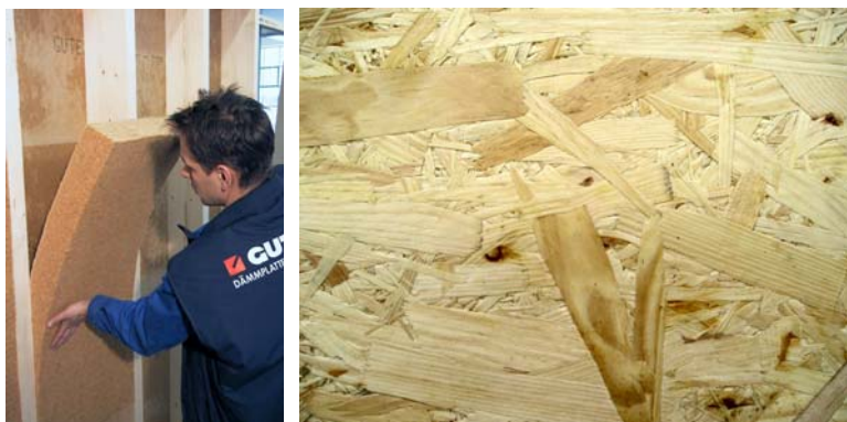
Link: Gebruik stijve isolatiematerialen (bron: Gutex) – Rechts: In de meeste houtskeletbouwen wordt een OSB (Oriented Strand Board) gebruikt als uitstijving en luchtdichting.
